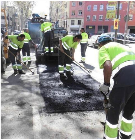
Brigada de reparació programada al carrer d'Espronceda.
