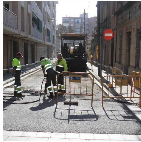
Renovació de paviment al carrer de Casas i Amigó.
