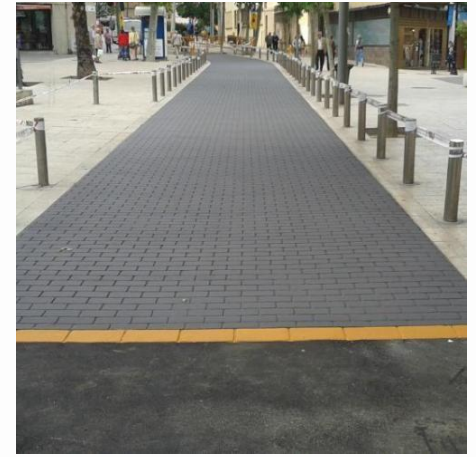
Paviment d'asfalt imprès al carrer de Sant Iscle.
