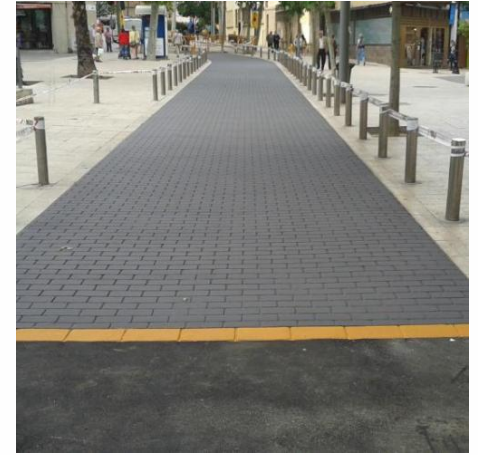
Pavimento asfalto impreso en la calle Sant Iscle.
