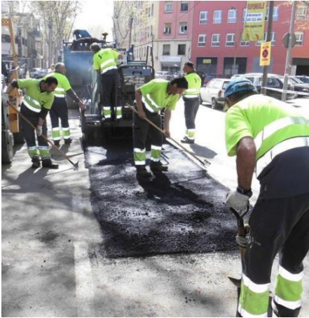
Brigada de reparación programada en la calle Espronceda.
