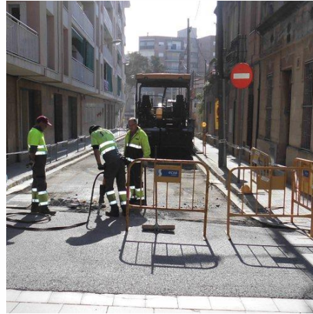
Renovación de pavimento en la calle Casas i Amigó.
