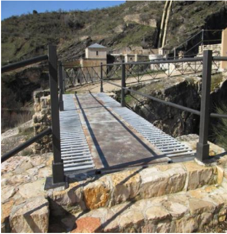
Pasarela actual acceso al margen derecho.
