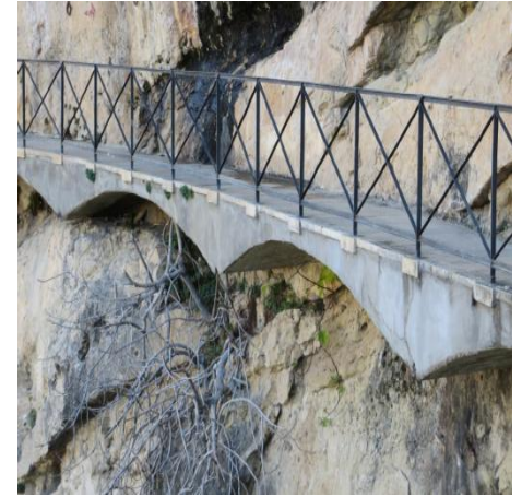
Pasarela en voladizo en ladera de montaña.
