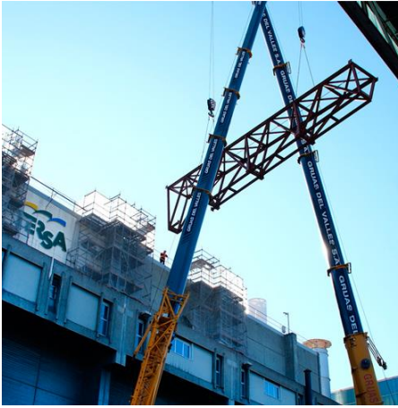
Montaje de estructuras metálicas.
