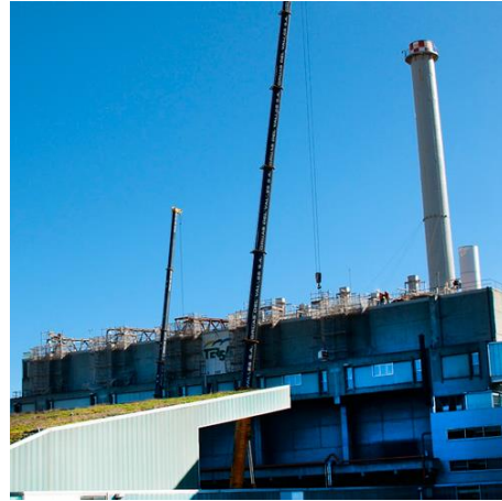
Coberta del fossat de residus.
