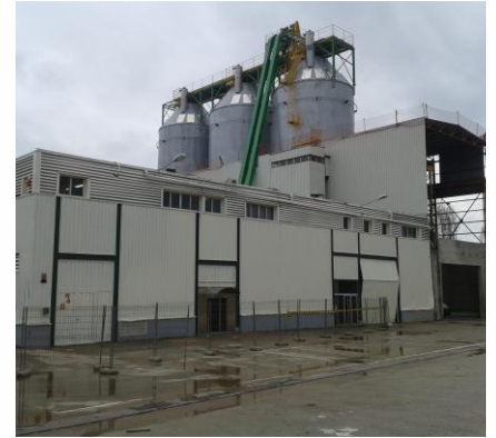
Silos de madera triturada.
