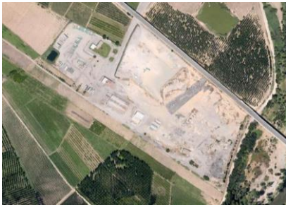
Vista aérea de la Planta
