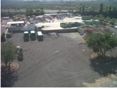
Vista aérea de la Planta
