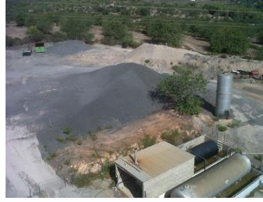
Acopio de material reciclado
