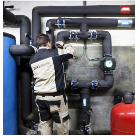
Manteniment d'instal·lacions interiors.
