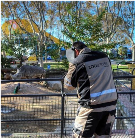
Soldadura de la tanca de la gàbia del rinoceront.
