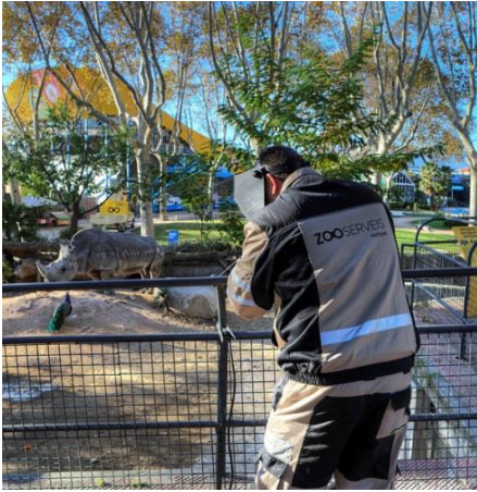
Soldadura vallado jaula rinoceronte.
