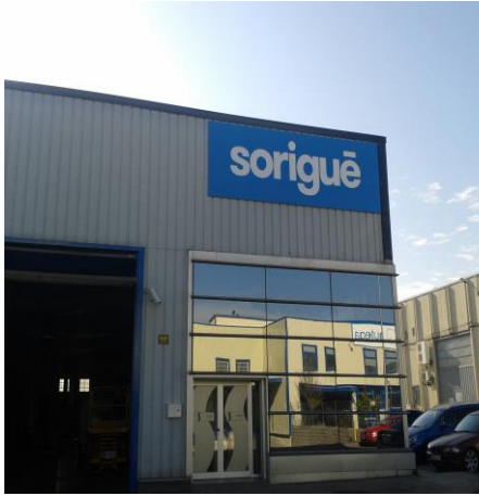
Sede ACSA Industrial Madrid.
