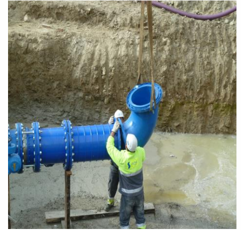
Actuación de montaje de tubería.
