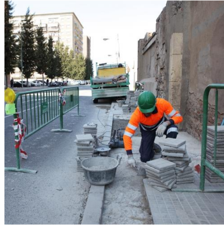
Trabajos de reparación de elementos urbanos.
