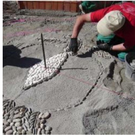
Trabajos especializados, empedrado granadino.
