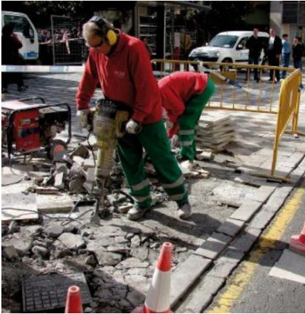
Trabajos de demolición de pavimento.
