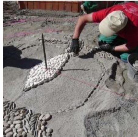
Travaux spécialisés, pavage de Grenade.
