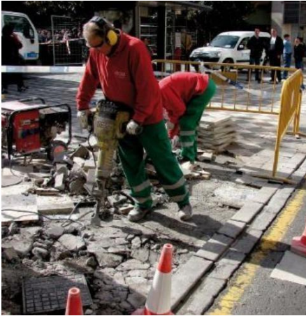
Travaux de démolition du pavage.
