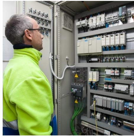
Manteniment d'equips elèctrics.
