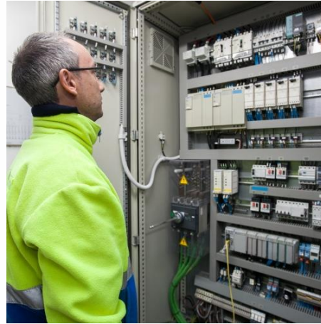
Mantenimiento de equipos eléctricos.
