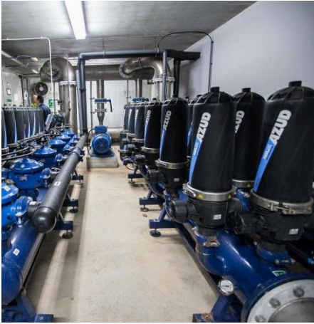
Mantenimiento de equipos mecánicos.
