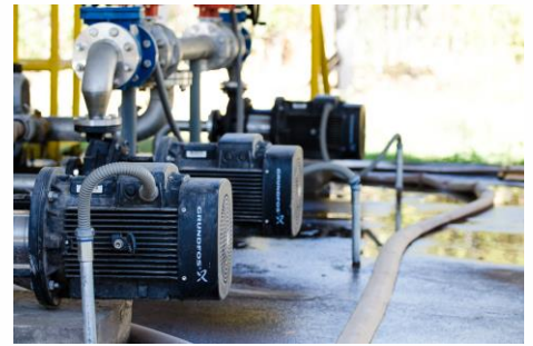
Bombes de pressió per a la rentada del filtre
