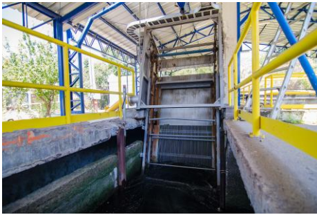
Vista de la reixa automàtica de desbast
