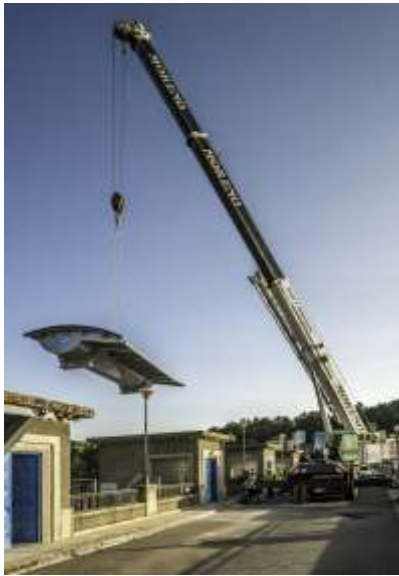
Maniobra de posicionamiento de la compuerta en el vano.
