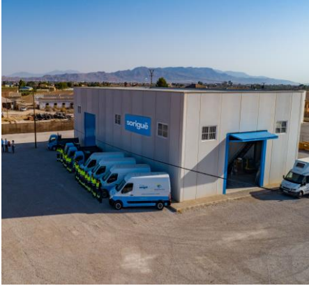
Instalaciones y medios asignados al servicio.
