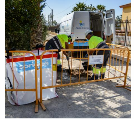
Reparación de una avería.
