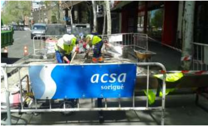
Actuación en la vía pública
