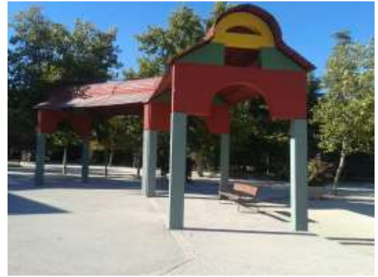
Rehabilitación de estructuras en el Parque de Berlín
