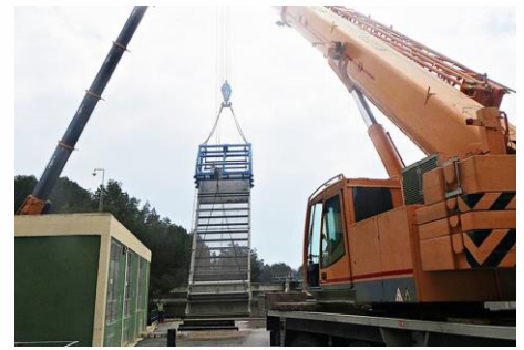
Inici de la instal·lació de la reixa amb dues grues
