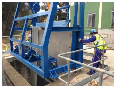
Fase final de la instal·lació de la reixa
