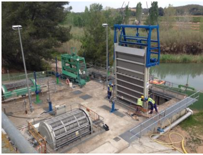
Vista general de la captació amb el filtre nou i la reixa nova
