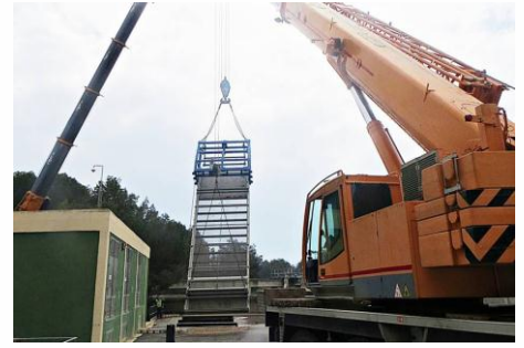
Inicio de las instalación de la reja con dos grúas.
