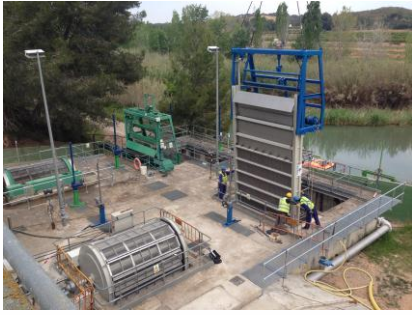
Vista general de la captación con el nuevo filtro y la nueva reja.
