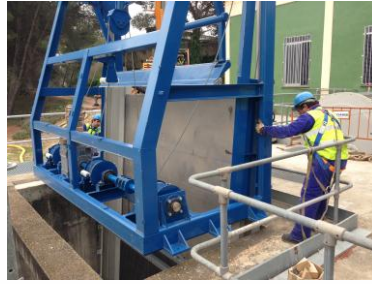
Fase final de la instalación de la reja.
