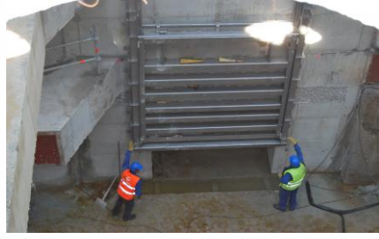
Instalación de una compuerta mural.
