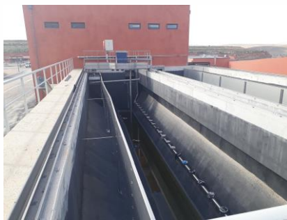
Pont longitudinal dessableur - dégraisseur.
