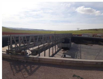
Vue de l'un des clarificateurs secondaires.
