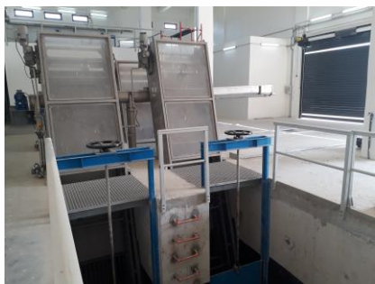
Grilles de nettoyage automatiques et vannes de prise d'eau.
