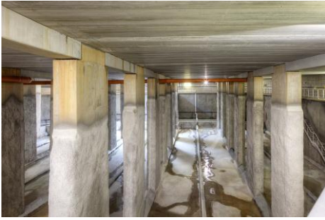
Vista general del depósito.
