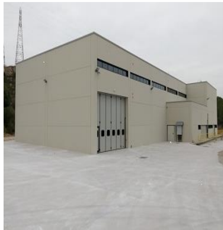
Vista exterior nave CN Ascó.
