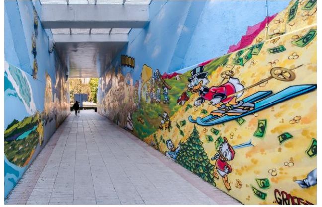
Reparación de paramentos verticales en túnel peatonal y posterior decoración con grafiti por artista local.
