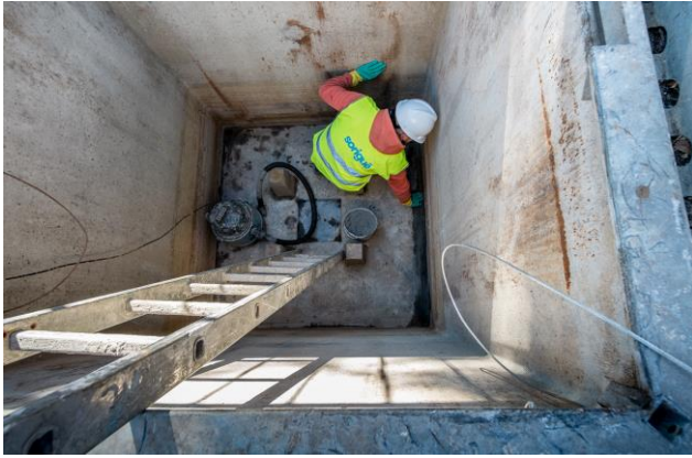
Impermeabilización y reparación de fosos donde se alojan los contenedores de recogida de basuras.
