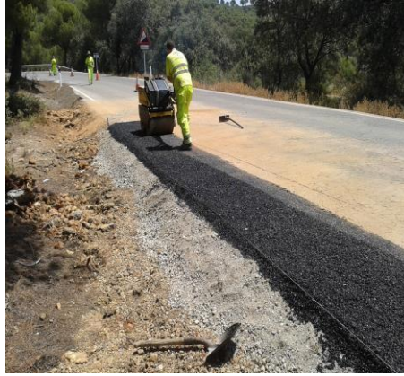
Reparación de carreteras.
