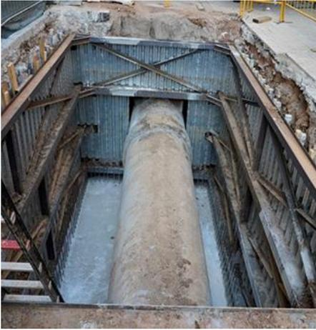
Tubería existente y excavación entibada.
