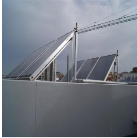
Instal·lació d'energia tèrmica.
