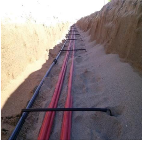
Positionnement et fixation du câble électrique et de fibre optique.
