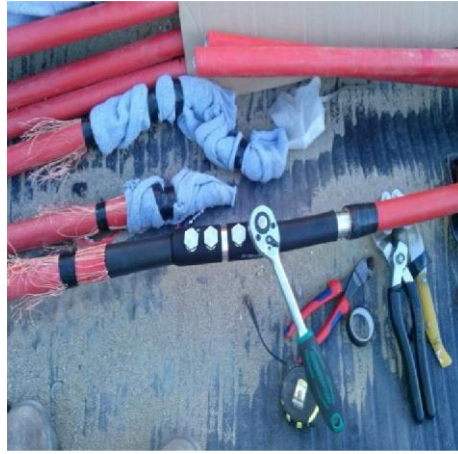
Aboutement unipolaire thermorétractable du câble moyenne tension.
