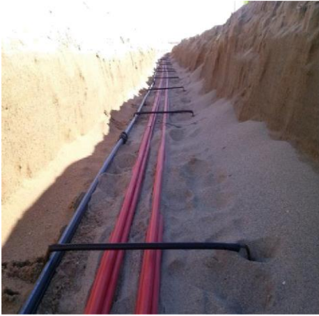
Posició i fixació de cable elèctric i fibra òptica.
