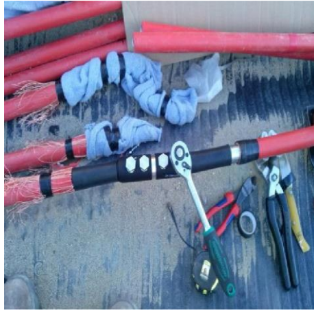
Empalmament unipolar termoretràctil de cable de mitjana tensió.
