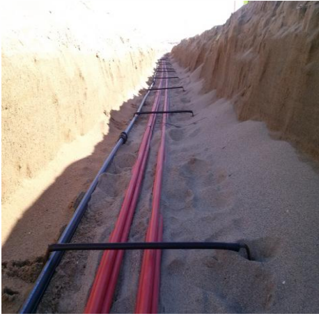
Posición y fijación de cable eléctrico y fibra óptica.
