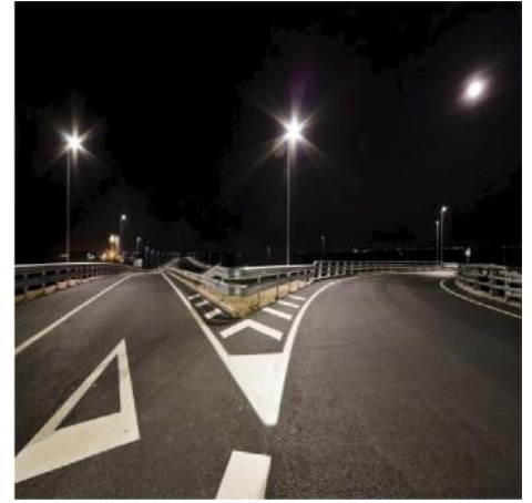
Échangeur Vilanova Nord.
