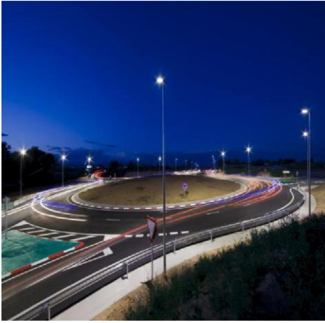
Échangeur Vilanova Sud.
