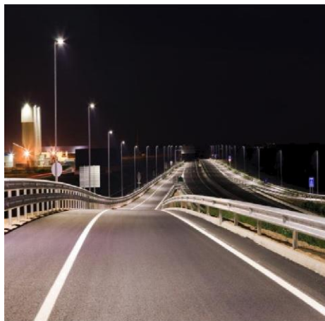
Accés a enllaç de Vilanova Nord des del viaducte.
