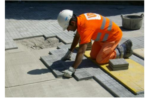
Reposición de aceras.
