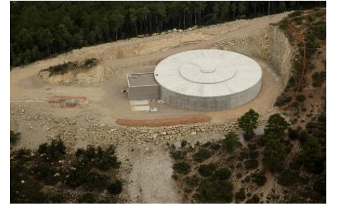
Depósito de rotura de carga y regulación.
