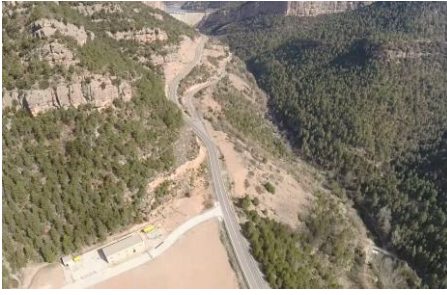
Estación de Bombeo General con la Presa del Embalse de la Llosa del Cavall al fondo.
