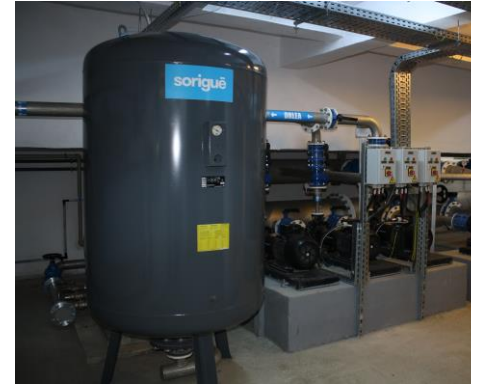
Nueva Estación de Bombeo
