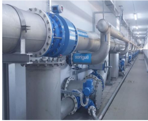
Nuevas tuberías en la galería de filtros
