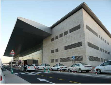
Marquesina acceso principal Aeropuerto
