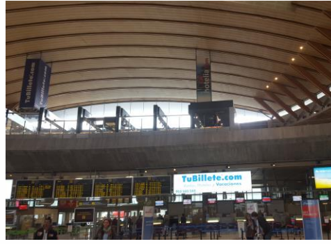
Interior cúpula cubierta hall principal
