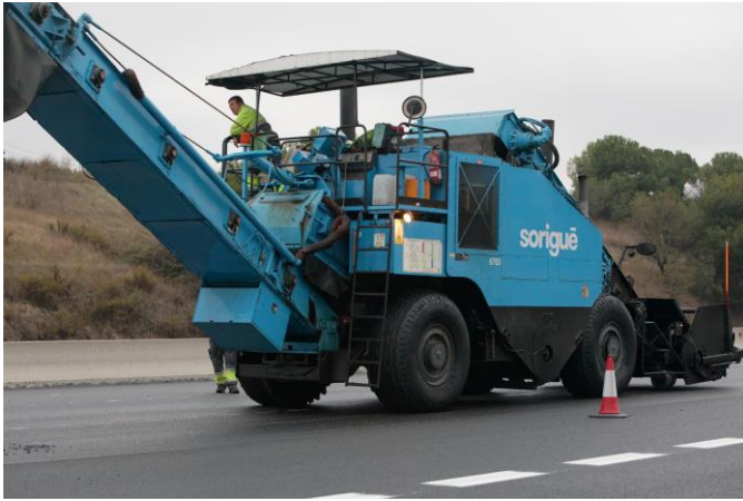
Homogeneïtzació de les mescles mitjançant una sitja de transferència
