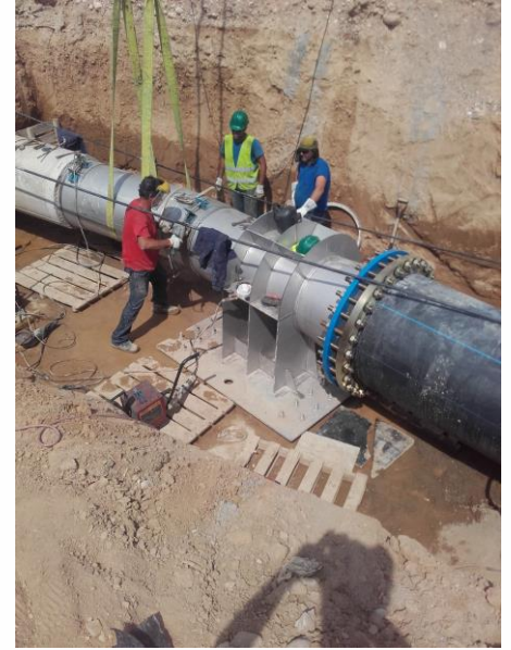
Trabajos mecánicos en punto de conexión.
