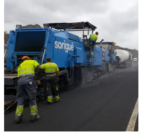
Extendido de la mezcla.
