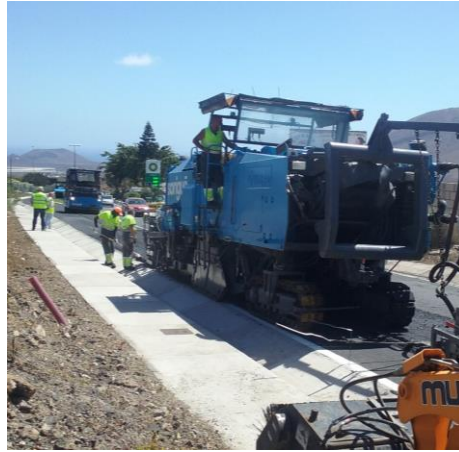
Compactación de reciclado en frío.
