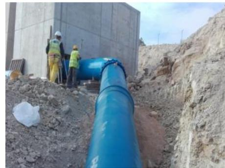
Vista de instalación de tubería FD DN800 C30 a su llegada a la arqueta de entrega.
