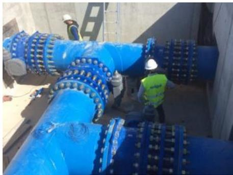
Vista de arqueta de conexión en fase de montaje de válvulas y carretes DN800 PN25.
