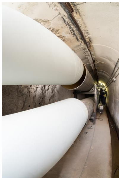
Maniobra de instalación de "pantalón" de transición entre las dos tuberías de \phi 700 y el tramo final de la conducción de \phi
