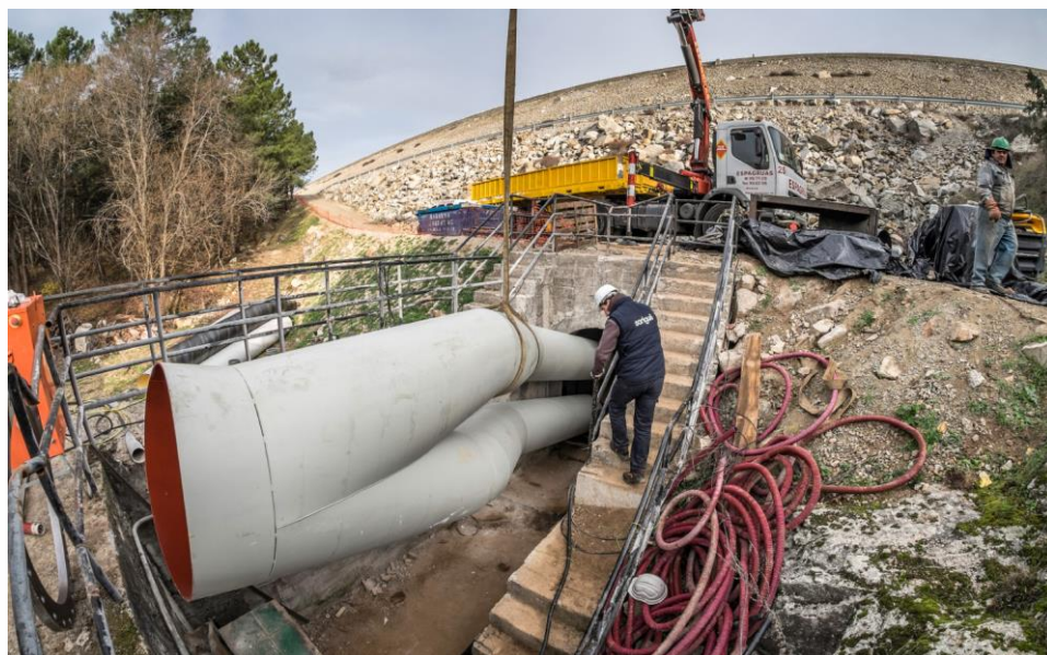
Maniobra de instalación de "pantalón" de transición entre las dos tuberías de \phi 700 y el tramo final de la conducción de \phi
