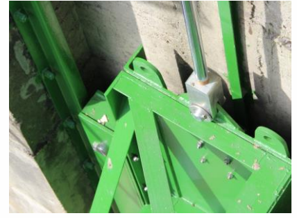
Detall del sistema d'aixecament de la comporta
