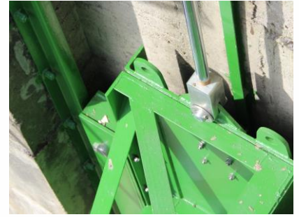
Detalle del sistema de izado de la compuerta
