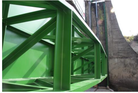
Detalle de la estructura de la compuerta
