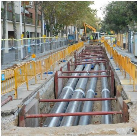
Colocación tubería en el interior de la zanja.
