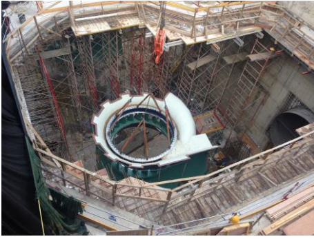
Instalación de las puertas de la turbina de generación.
