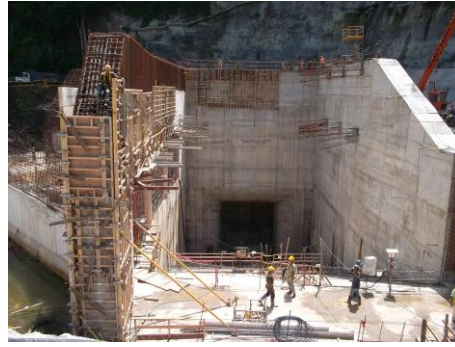
Trabajos en la toma de la presa.
