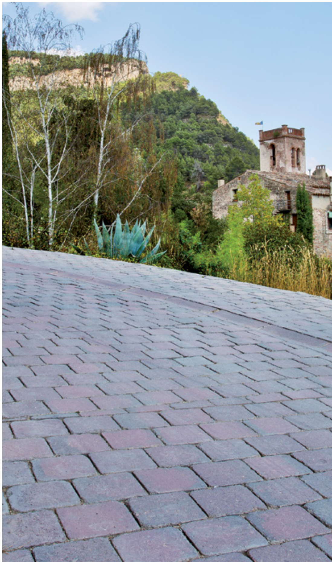
Urbanització i pavimentació. Barri El Raval, Gallifa.
