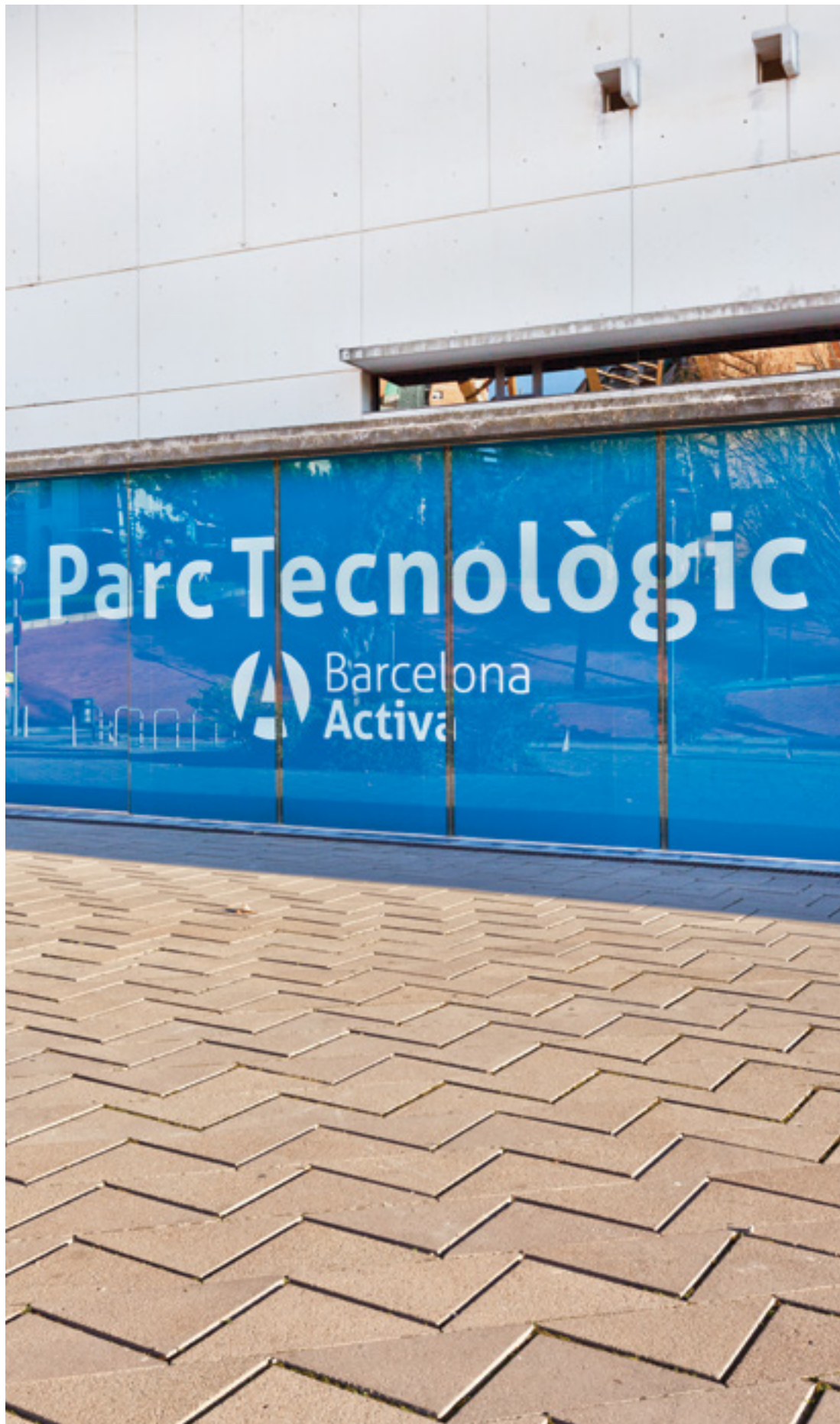
Paviment exterior. Parc Tecnològic Barcelona Activa.
