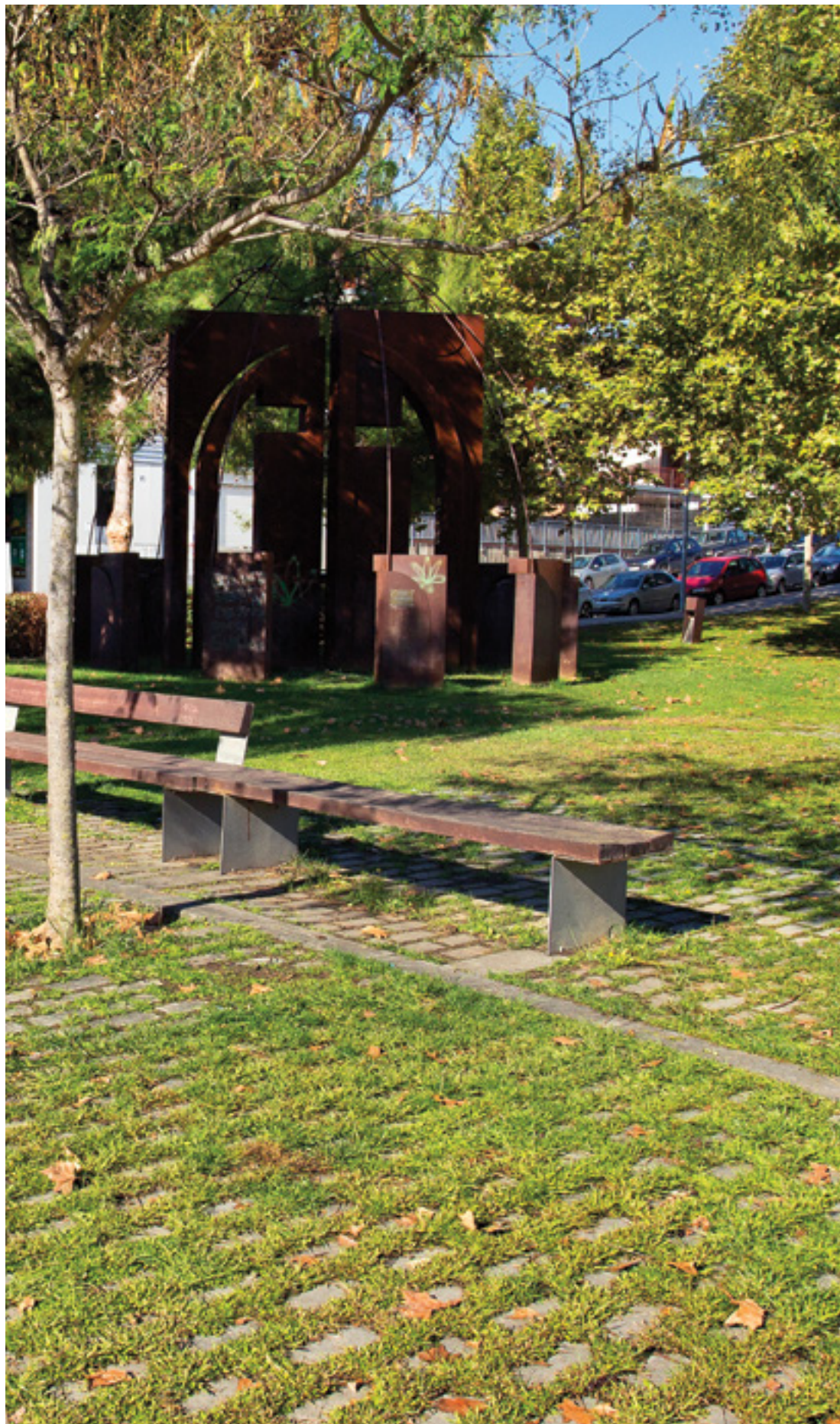
Urbanització i pavimentació del Parc de la Foneria. Sant Vicenç dels Horts.
