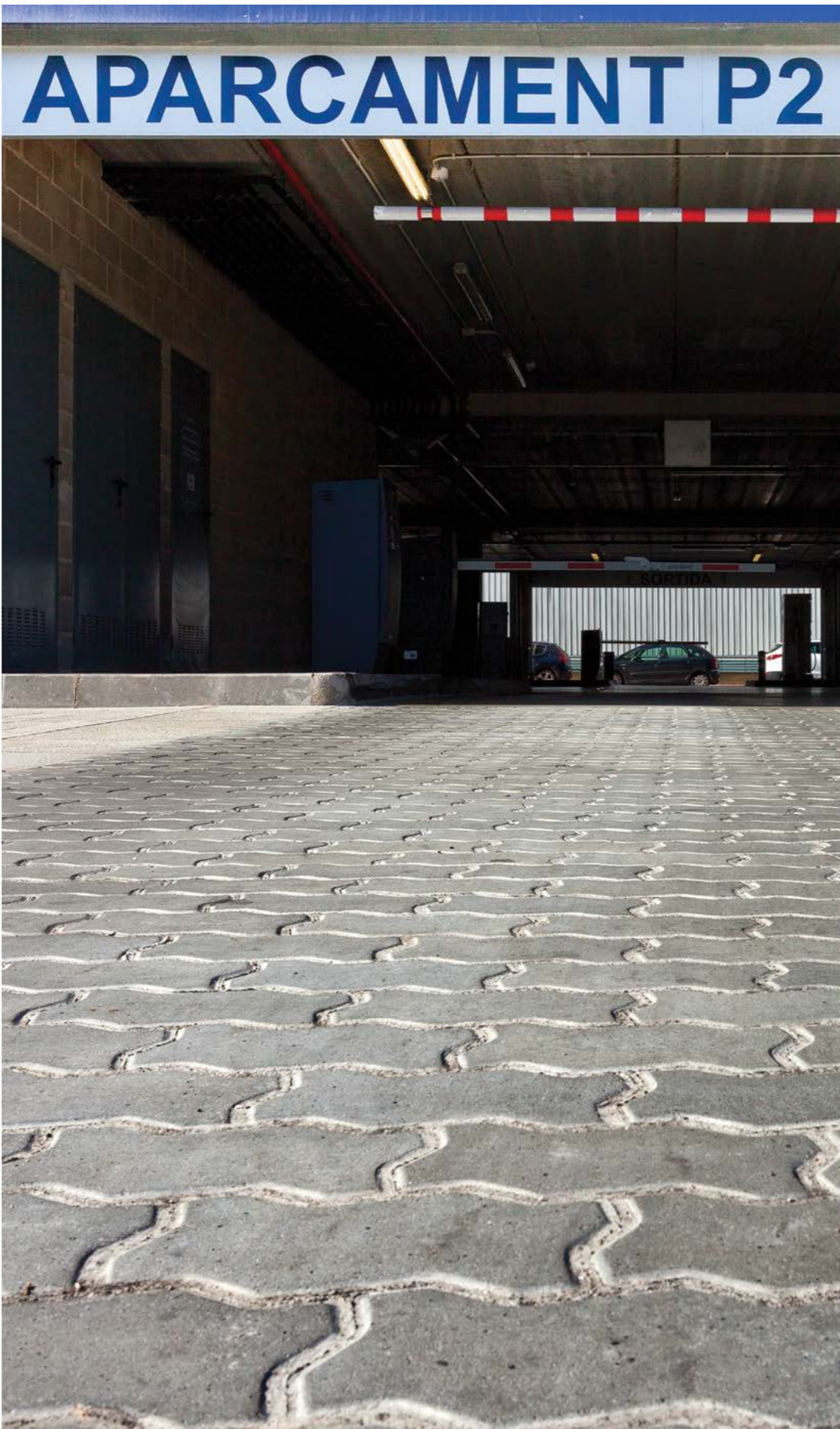
Pavimento de aparcamiento de edificios de oficinas en Mercabana, Zona Franca, Barcelona.
